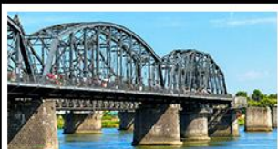
สะพานหวาดถานตง
