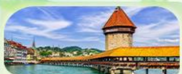
สะพานไมซ์าเปค
